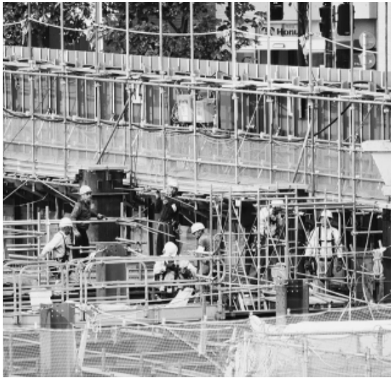
都内の工事現場
