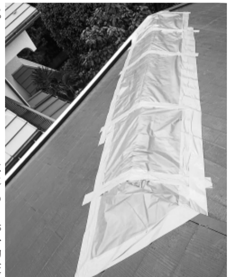
応急処置した屋根
