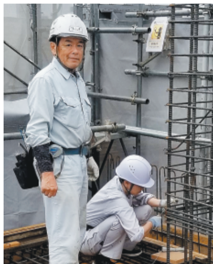
本間廣さんとコンクリート打設前の作業をする美帆さん(右)
