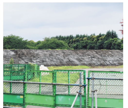
5mも積み上げられた残土
