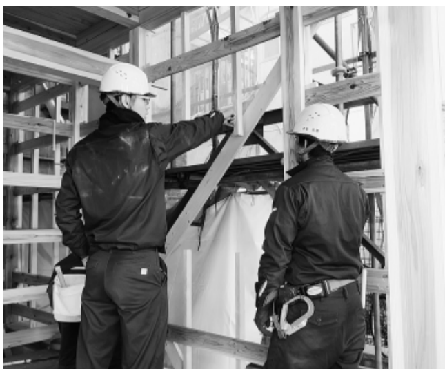
実践的に学ぶ木造軸組み実習棟実習
