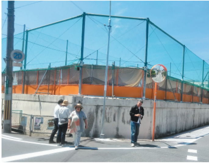
ブロック塀の撤去が完了した高槻市立城南中学校の現場
