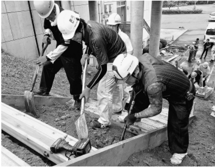
「しおかぜ球場」の階段改修の作業を世田谷区職員を含めて21人で行ないました
