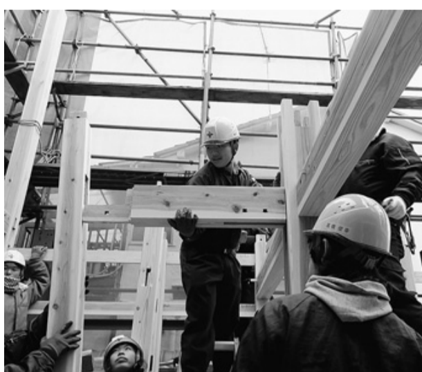
21期生「実習棟実習」の上棟の様子(2017年1月)
