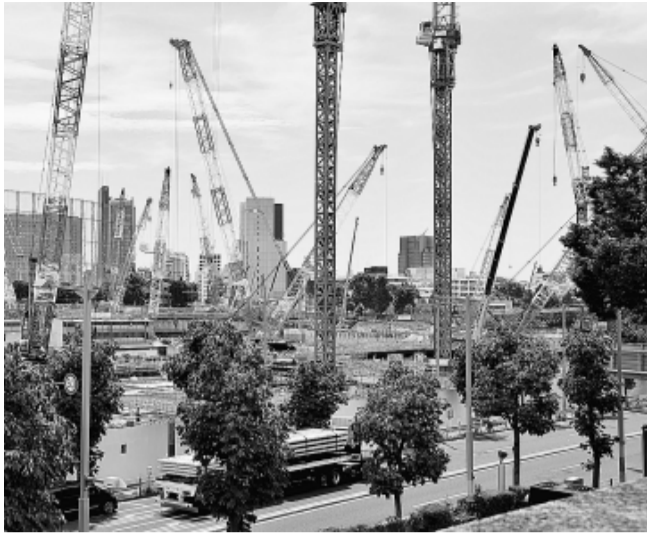
クレーンが林立し工事がすすむ新国立競技場の現場
